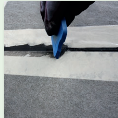
Abziehen, Klebebänder entfernen und Fugenoberfläche glätten
