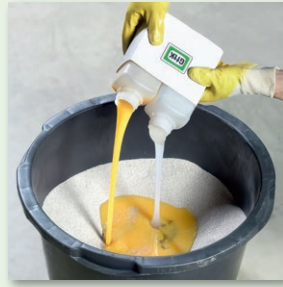
Die beiden Bindemittelkomponenten zumischen
