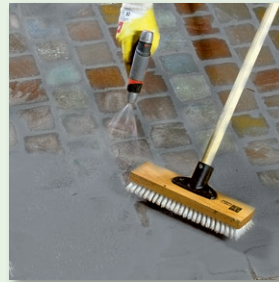
diagonal zur Fuge abreinigen
