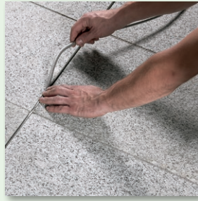
Fugentiefe durch PE-Rundschnur fixieren
