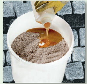
Bindemittelkomponente zugeben
