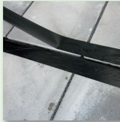
Fugenraum säubern und Kanten abkleben
