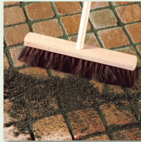
Mittels feuchtem Besen abfegen
