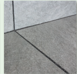
Nach vollständiger Erhärtung überschüssigen Sand entfernen.
