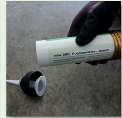
Kartusche in die Fließpistole einsetzen und verschließen
