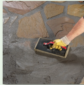
diagonal zur Fuge abreinigen
