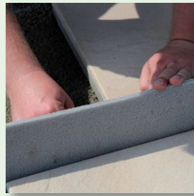
vdw 884 FugenBand im Bettungsmörtel einbringen
