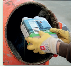
Bindemittelkomponenten zugeben
