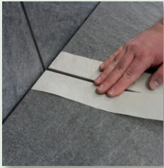
Oberfläche säubern und Kanten abkleben
