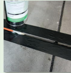
Fugenflanken mit Primer grundieren
