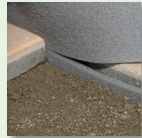
vdw 884 FugenBand 10 mm tief abtrennen
