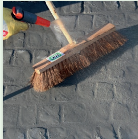
Erhärten des Mörtels auf der Oberfläche vermeiden
