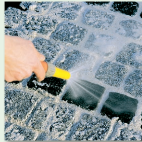
mit Wassersprühstrahl und feuchtem Besen abreinigen
