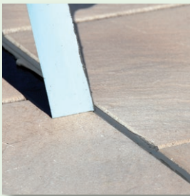
Klebebänder direkt im Anschluss entfernen
