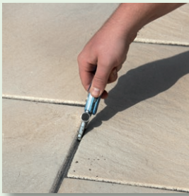
Hierzu Schnittkante FugenBand einkerben
