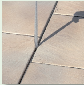
Fugenbandreste komplett entfernen
