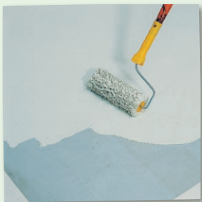
Die 2. Applikation frühstens nach ca. 12 Stunden auftragen
