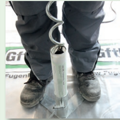
Komponenten in der Kartusche im Gebindehalter mischen
