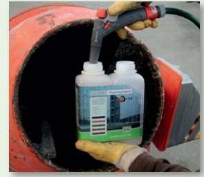
Max. 1 l Wasser hinzufügen und homogen anmischen
