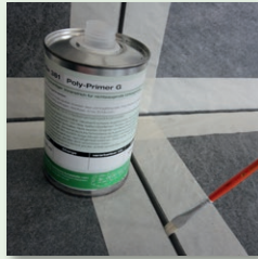
Fugenraum säubern und Fugenflanken primern
