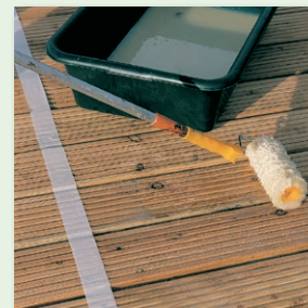
Mittels Fellrolle verteilen
