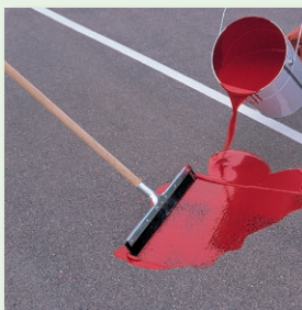
Material vollständig ausbringen und mit Gummischieber verteilen
