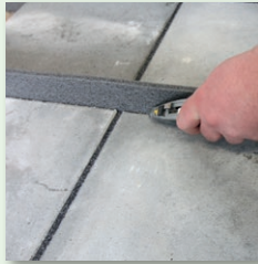
Dehnungsfugenband \geq 10 mm tief freischneiden
