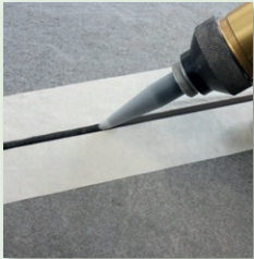
Kanüle passend kürzen und vdw 385 in die Fugen verpressen
