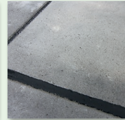
Vor der Aushärtung Klebebänder entfernen
