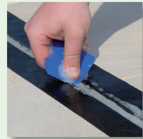
Fugenmasse verdichten und abziehen
