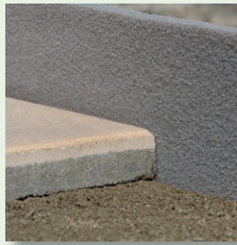
Anschließenden Belag druckfrei verlegen
