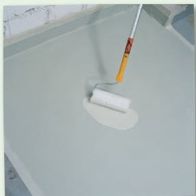
... und mit Fellrolle verteilen
