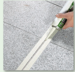
Fugenmasse einbringen
