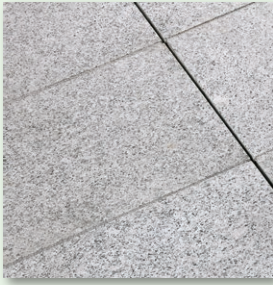
Oberfläche und Fugenflanken vorbereiten
