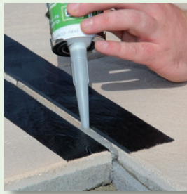
Kanten sauber abkleben und vdw 885 FugenFlex mit Druck blasenfrei einspritzen
