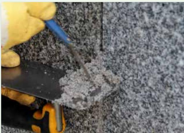
Durch eine Verminderung des Anmischwassers, kann **vdw 800** für senkrechte Fuge auch spachtelfähig angerührt werden.
