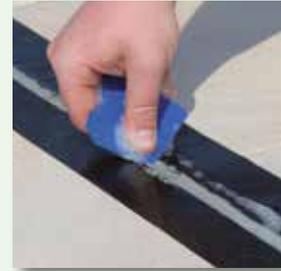
Fugenmasse verdichten und abziehen
