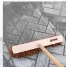
Anschließend nachsandern und erneut abrütteln. Danach rückstandsfrei abfegen und ggf. Fasen freilegen
