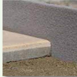
Anschließenden Belag druckfrei verlegen
