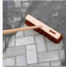
Wichtig, Nur auf trockenen Belägen verwenden. vdw VarioSand einfügen und von der Oberfläche abfegen
