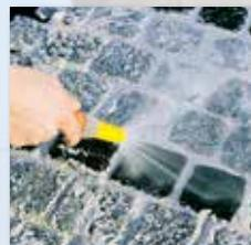
mit Wassersprühstrahl und feuchtem Besen abreinigen
