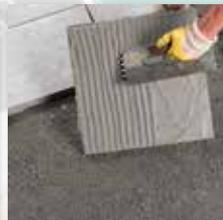
Bei Platten unterseitig vdw Universal-HaftBrücke auftragen
