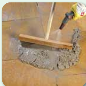
Etaler avec raclette en caoutchouc et jet d'eau
