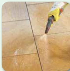
Mouiller la surface à la saturation
