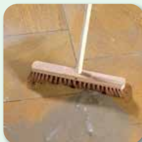
Eliminer les derniers restes de mortier / grains de sable avec un balai coco
